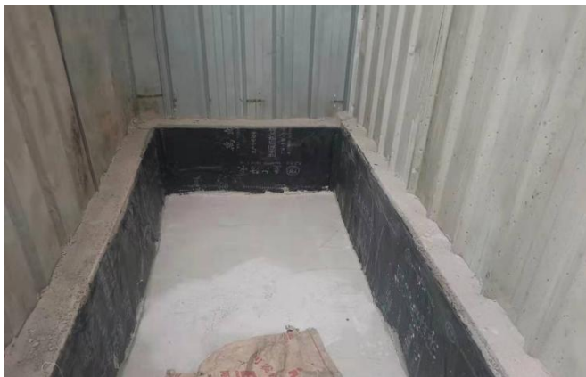
危废间防渗地面
