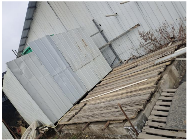
冷却循环水池
