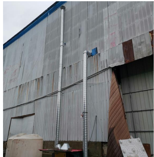
15m 高废气排放口
