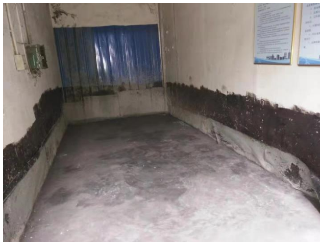
危废间地面防渗
