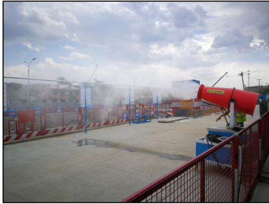
图 1、雾炮机洒水降尘
