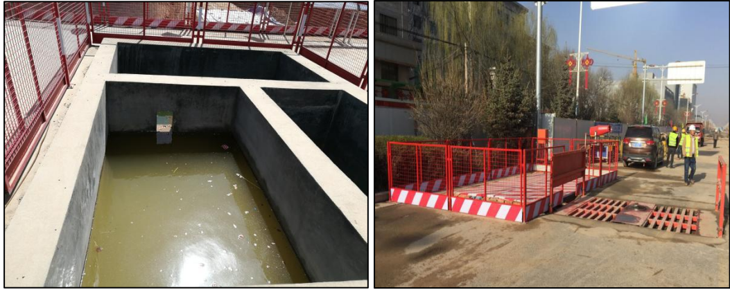
图 1、沉淀池及冲洗平台
