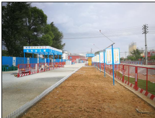
图 3、场地硬化及围挡
