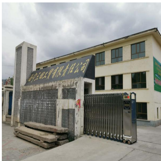
南侧厂区大门
