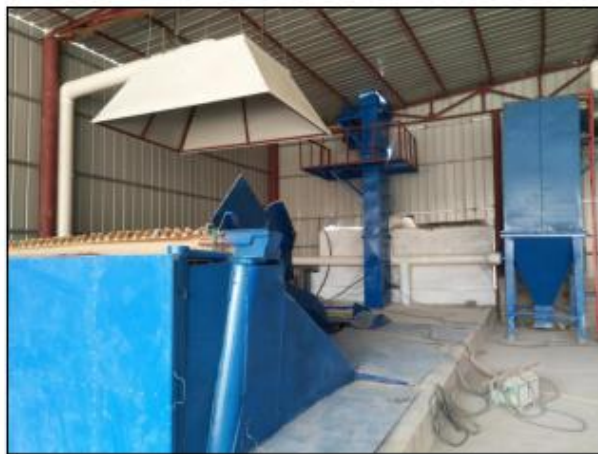
振动给料机破碎工序除尘
