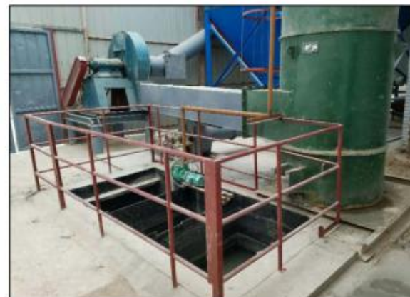
脱硫除尘塔循环水池
