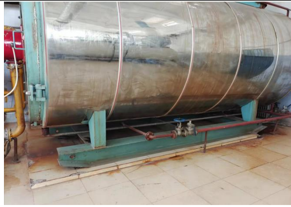
锅炉基础减振
